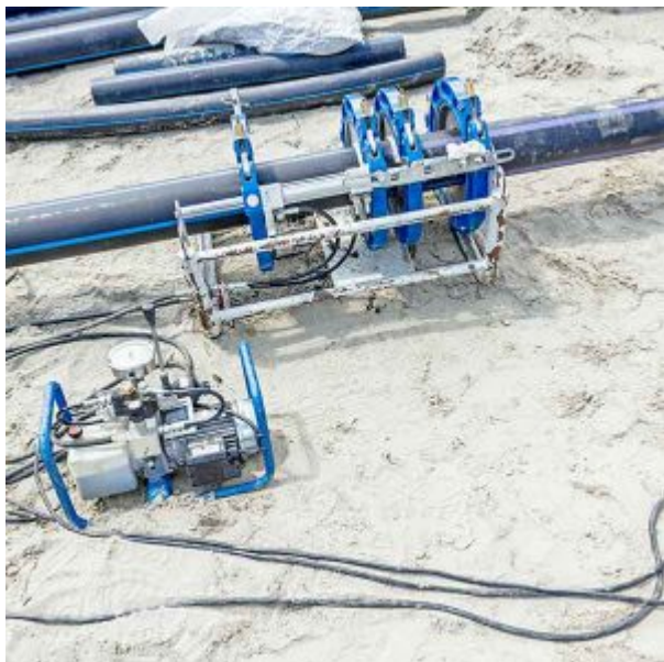
Corso Saldatori Tubi Elementi in Polietilene
